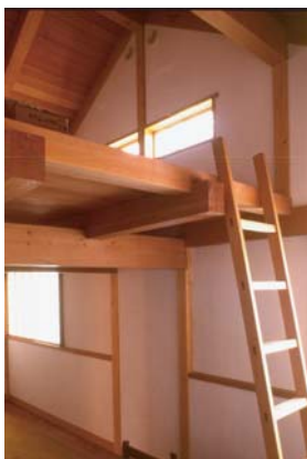
図3 骨太の材で組まれたロフト
