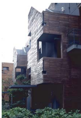
図4 杉板特殊型枠が特徴的な階段室
