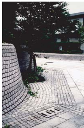
図12 街角も敷地内で擁壁をセットバック
