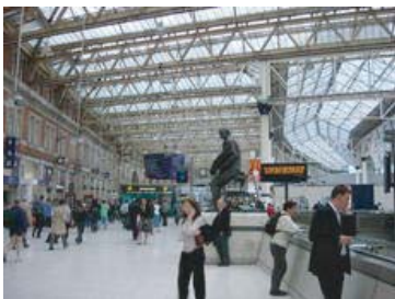
図1 ウォールタールー国際駅
